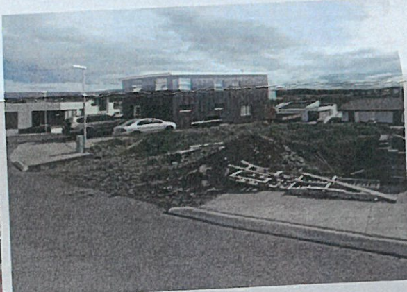
Horft á lóð Urðarbrunn 16.
