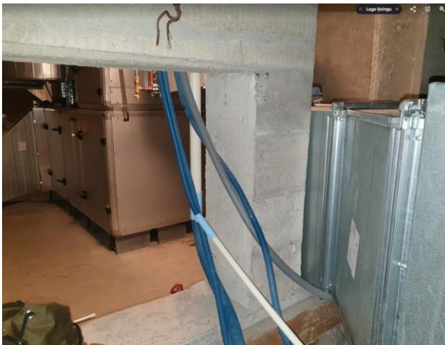
Mynd 2. Raflagnir liggja í gegnum skriðgöt en þessu þarf að loka á loftþéttan hátt.
