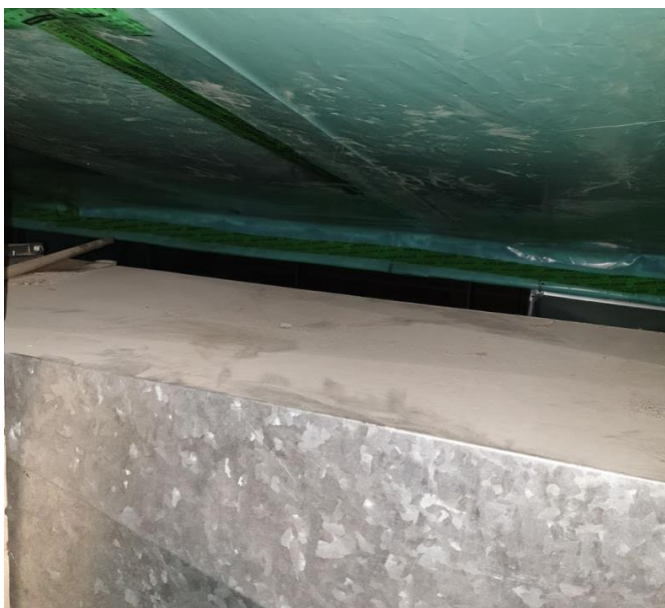
Mynd 1. Á myndinni má sjá rakavarnarlag sem var endurnýjað auk nýrra stokka.
